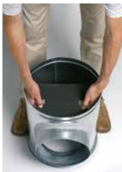
Installation du déflecteur acoustique et aéraulique dans le caisson piquage
